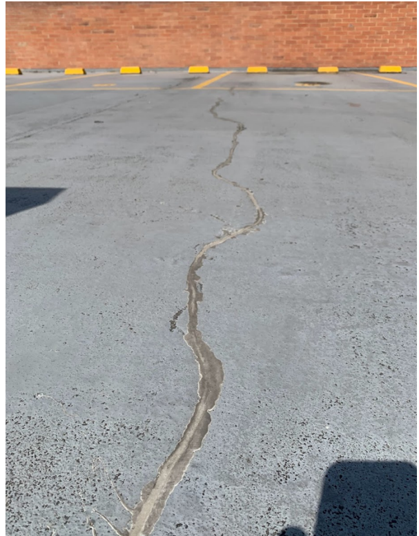
Reparación grietas de parqueaderos
