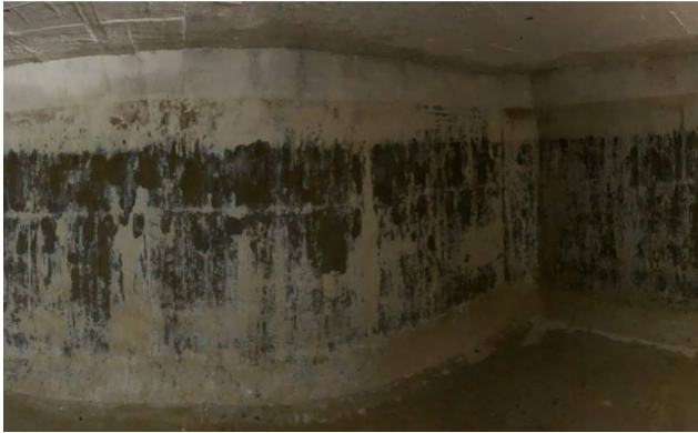
Antes de la impermeabilización Febrero 2023
