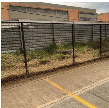
Limpieza del antiguo camino de obreros
