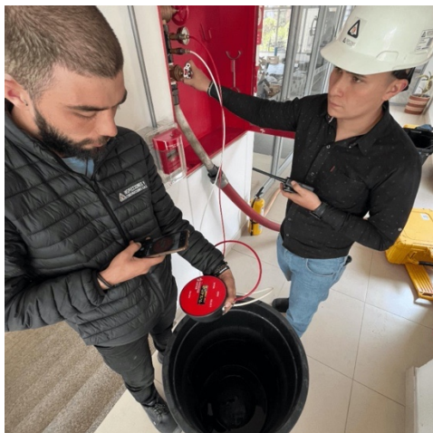
Pruebas Hidrostáticas en gabinetes
