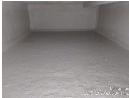
Después de la impermeabilización Julio 2023
