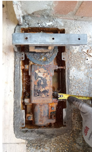
En Marzo se reajustaron y remontaron las puertas peatonales. Se cambiaron algunos elementos del eje de las puertas y se hizo mantenimiento a las bisagras de piso que están en buen estado.
